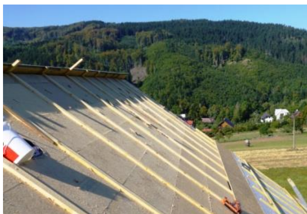
Obr. 13) Plošné zakrytí sedlové střechy
