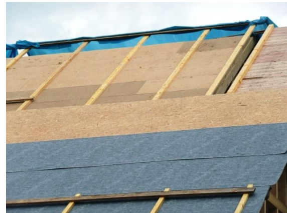
Obr. 14) Přesah střechy u štítu
