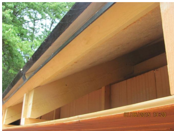
Obr. 9) Založení desky Pavatex u okapu
