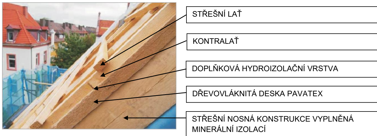
Obr 10) : Uspořádání materiálů s deskami PAVATEX nad krokviemi – praktická realizace.
