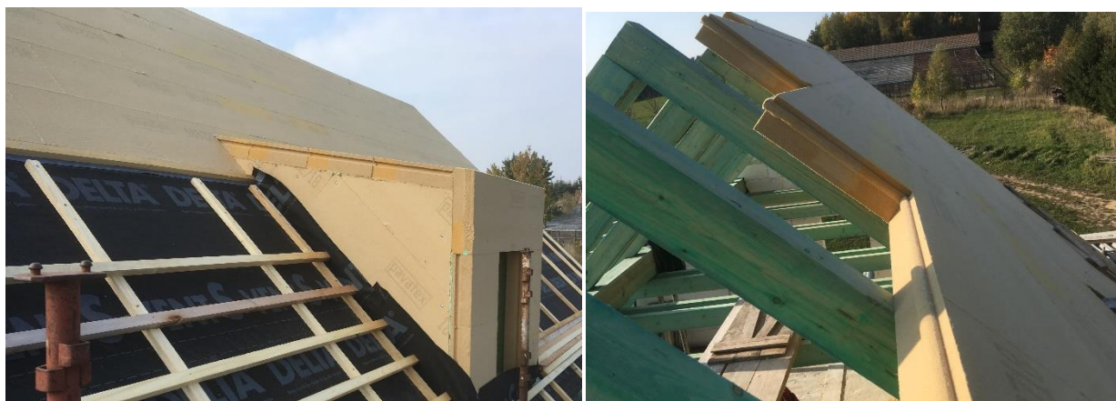
Obr. 2), 3): Obložení vikýře a uložení desky Isolair 140 mm na krokvích
