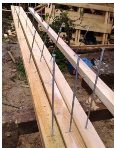
Obr. 3) schéma uspořádání šikmých vrutů Twin UD
