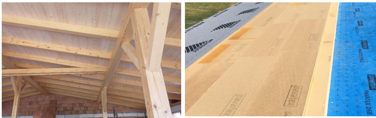
Foto 10, 11) Dřevovláknité desky PAVATHERM 120 mm + ISOLAIR 100 = 220 mm. Vzduchotěsná parobrzdňá fólie PAVATEX DSB 2
