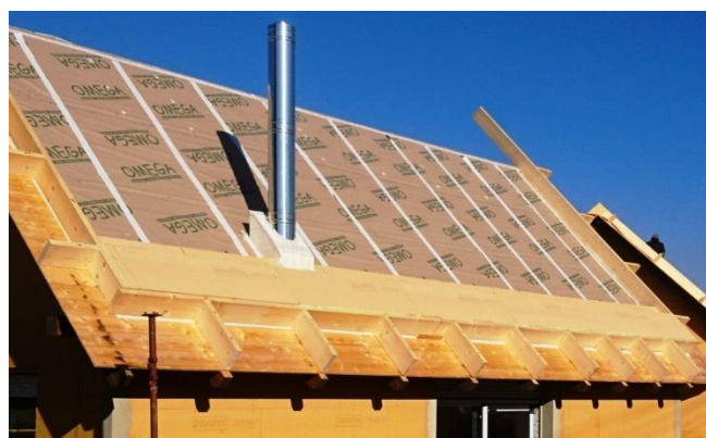
Foto 8, 9) Dřevovláknité desky ISOLAIR 2 x 120 = 240 mm
