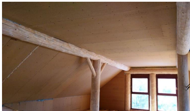
Obr. 6A, 6B : Laťový rošt vyplněný tepelnou izolací, souvislá plocha desek Pavatex připravená k povrchové úpravě
