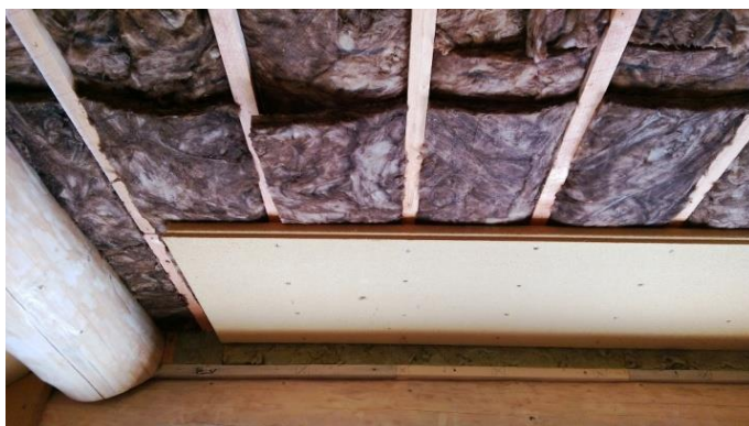
Obr. 6A, 6B : Laťový rošt vyplněný tepelnou izolací, souvislá plocha desek Pavatex připravená k povrchové úpravě
