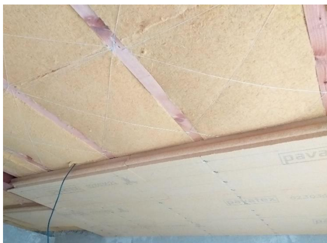
Obr. 10A, 10B : Ilustrativní foto rekonstrukce půdy na podkroví z interiéru
