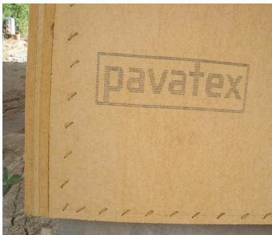
Obr. 9, 10: Úprava a sponkování desek na nároží a kolem okenního otvoru
